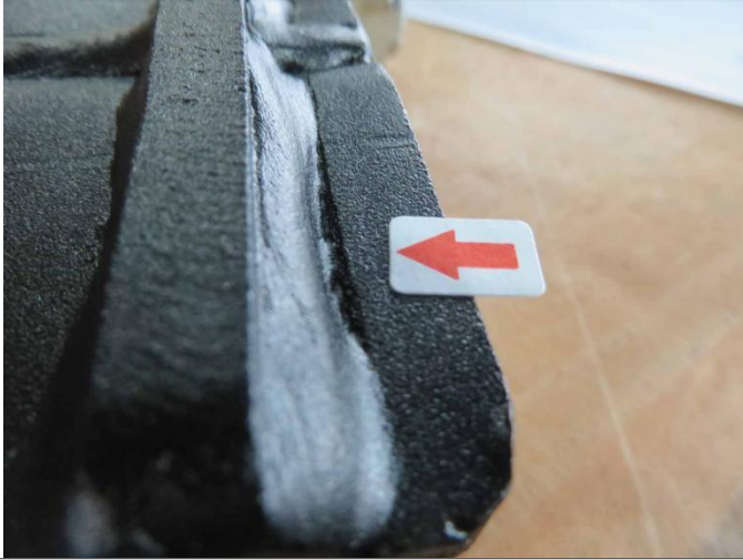
焊缝表面咬边-严重
